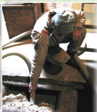
Izolace trámových stropů
