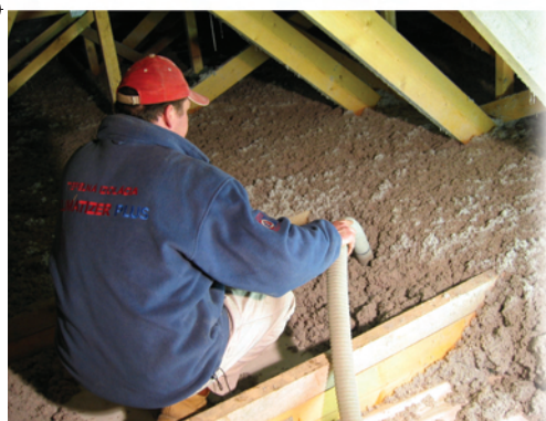
Dokonalé zateplení podhledů střech ze sbíjených vazníků
