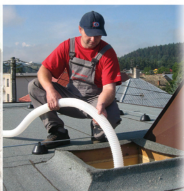
Dodatečné zateplení dvouplášťových střech
